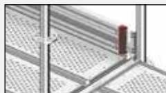
Montaż krawężnika stalowego
